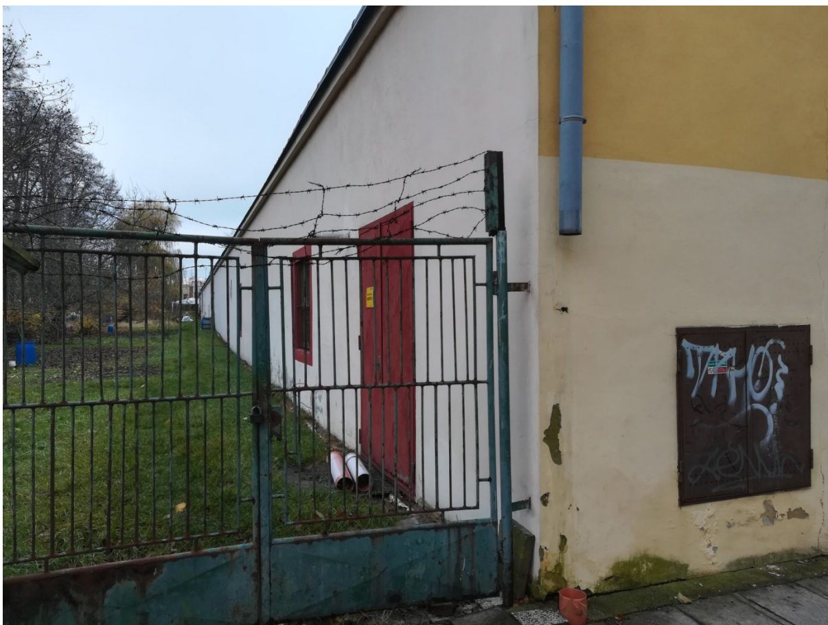
Degradace obvodového zdiva od zatékání od dešťových vod - chybějící svod, ul. Bezručova
