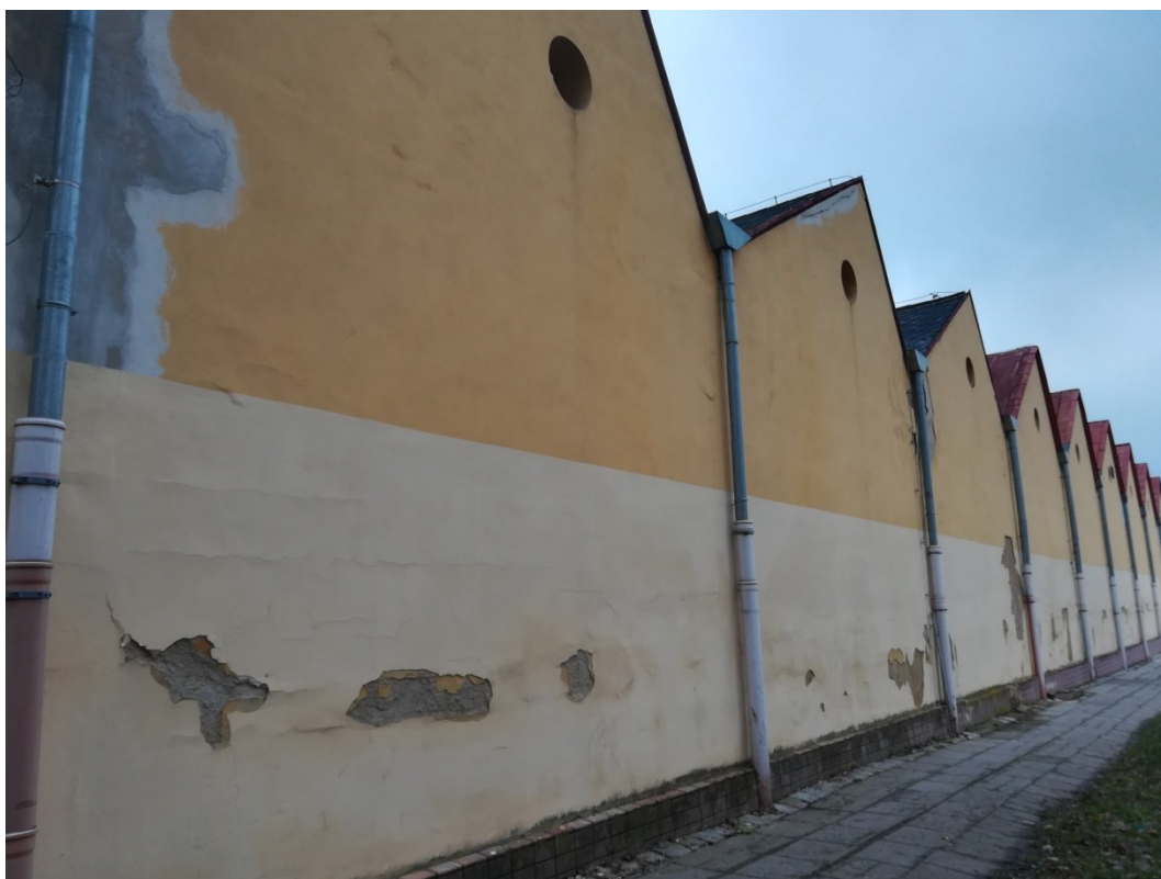
Degradace obvodového zdiva od vztlínající vlhkosti a zatékání z mezistřešních žlabů, patrné i dílčí opravy vyvolaných škod, - zatékání dlouhodobé , ul. Bezručova
