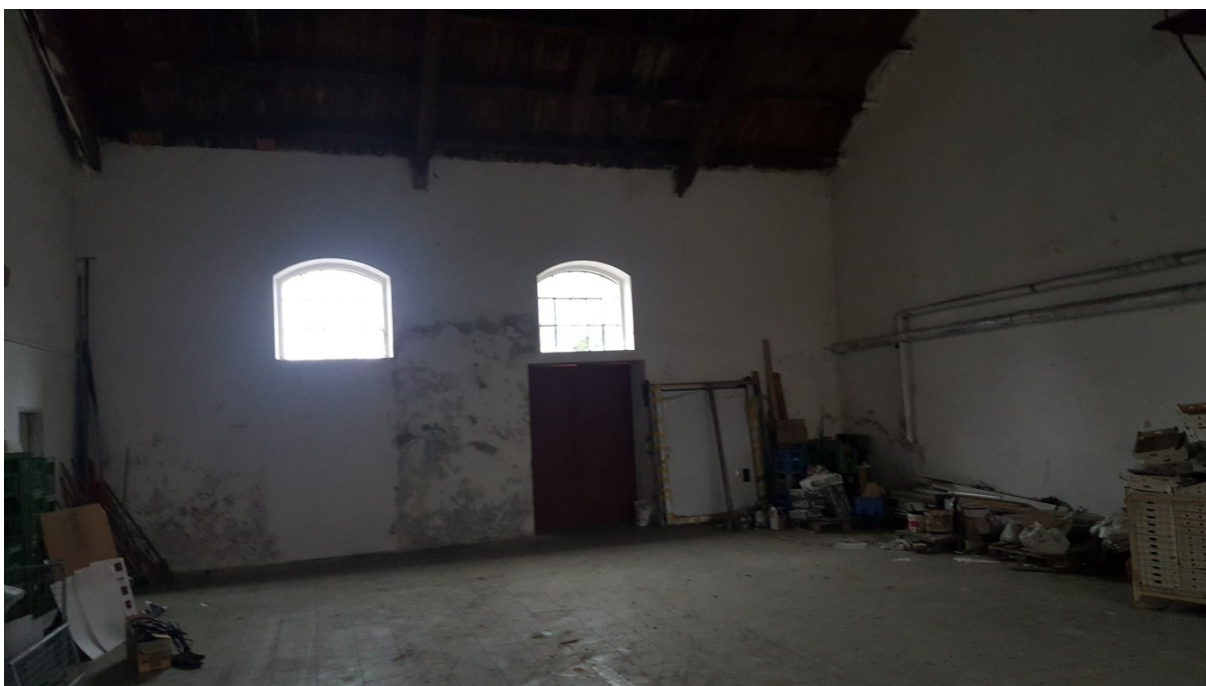
Degradace obvodového zdiva od vztlínající vlhkosti
