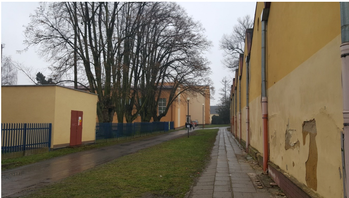
Degradace obvodového zdiva od vztlínající vlhkosti, ul. Bezručova
