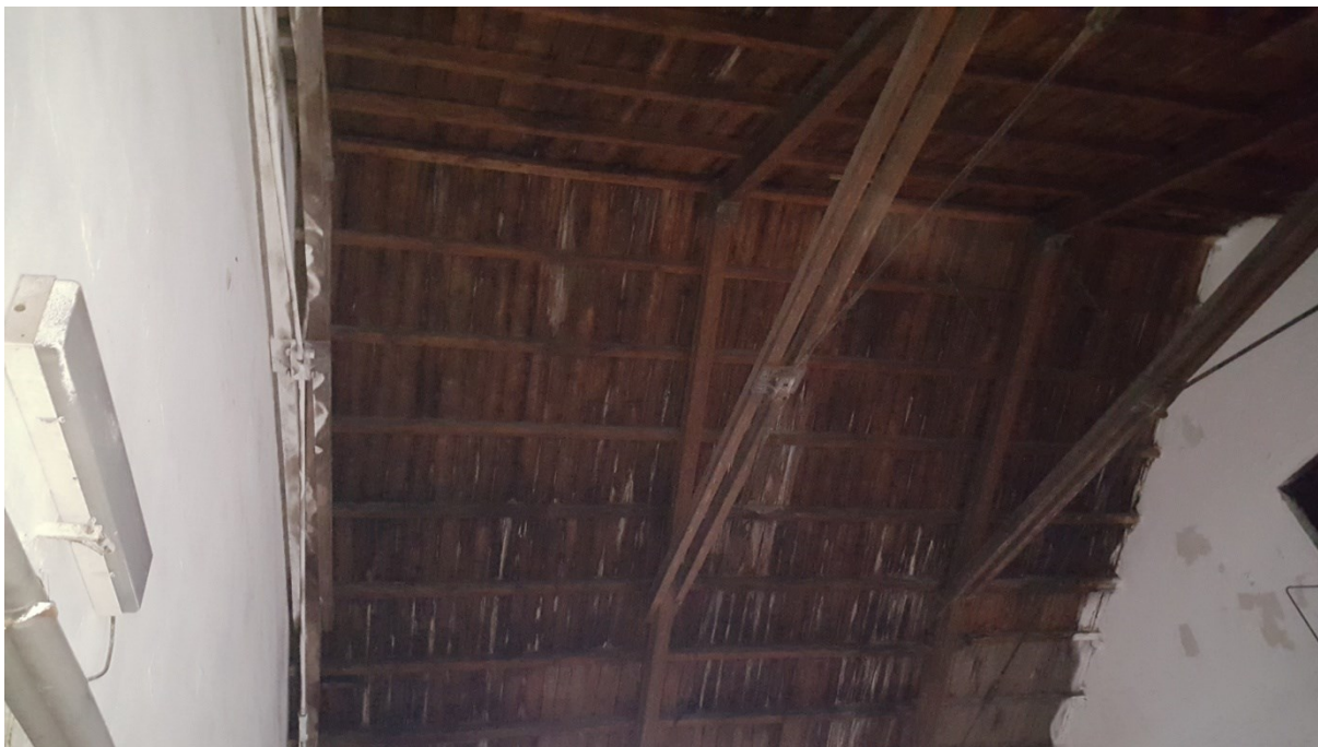
Na dnešní normové hodnoty zatížení nedostatečně nadimenzované nosné konstrukce
