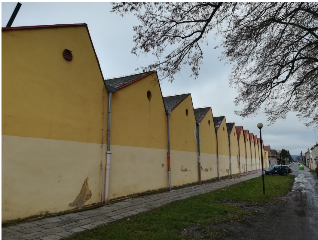
Degradace obvodového zdiva od vztlínající vlhkosti a zatékání z mezistřešních žlabů , ul. Bezručova
